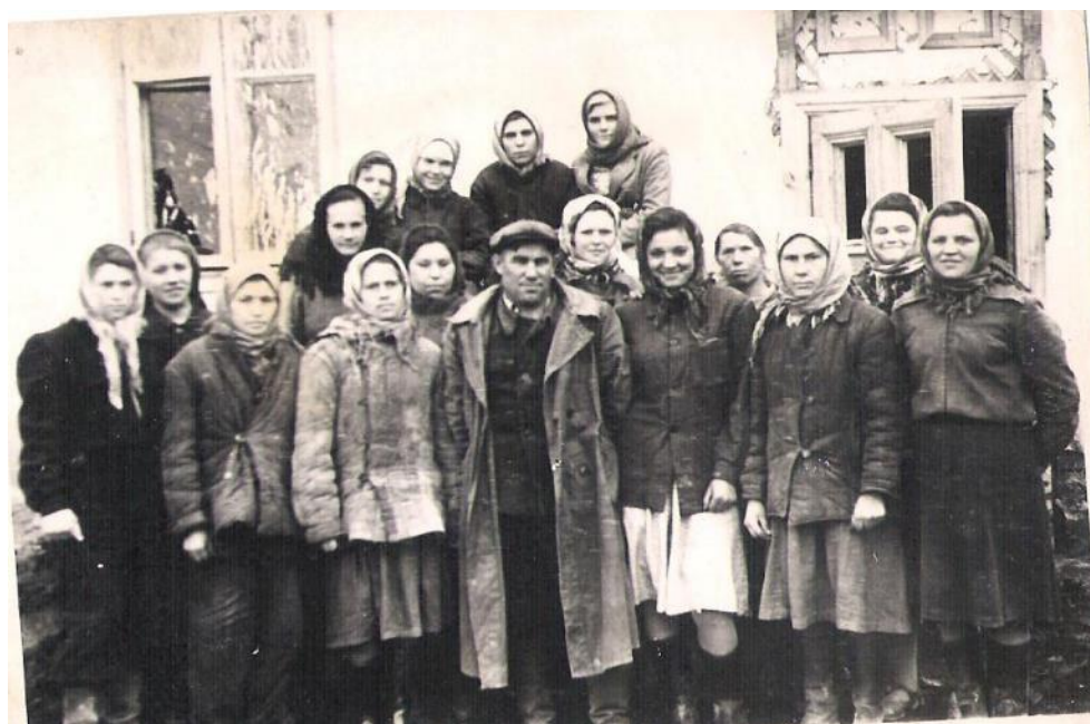
Строительство посёлка «Ясная Поляна» прораб Королёв П.П.
